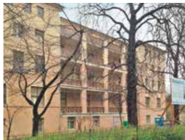
Detská škôlka Waldemar, Berlín (DE) • Stavebný prvok: Pavlač • Veľkosť objektu: 148 m 2 • Systém: Triflex BIS, Triflex BTS-P • Dokončenie: 2013
