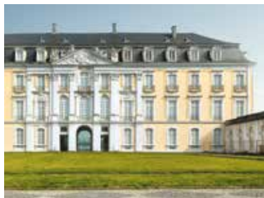
Zámok Augustusburg, Brühl (DE) • Stavebný prvok: Terasa • Veľkosť objektu: 2 500 m 2 • Systém: Triflex BWS • Dokončenie: 2014
