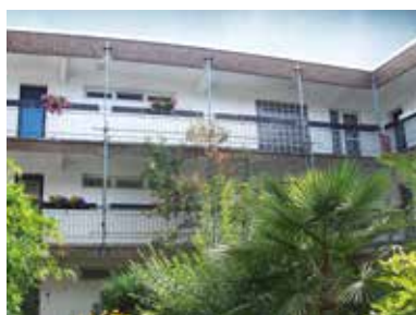
Obytný dom, Kaarst (DE) • Stavebný prvok: Pavlače • Veľkosť objektu: 200 m 2 • Systém: Triflex BTS-P (S1) • Dokončenie: 2013
