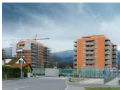
Výškové budovy, Solothurn (CH) • Stavebný prvok: Balkóny • Veľkosť objektu: 300 m 2 • Systém: Triflex BTS-P, Triflex BIS • Dokončenie: 2014
