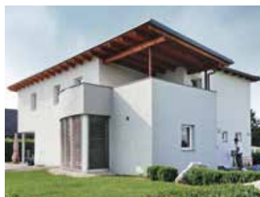
Rodinný dom, Amstetten (AT) • Stavebný prvok: Balkóny • Veľkosť objektu: 18 m 2 • Systém: Triflex Creative Design • Dokončenie: 2013
